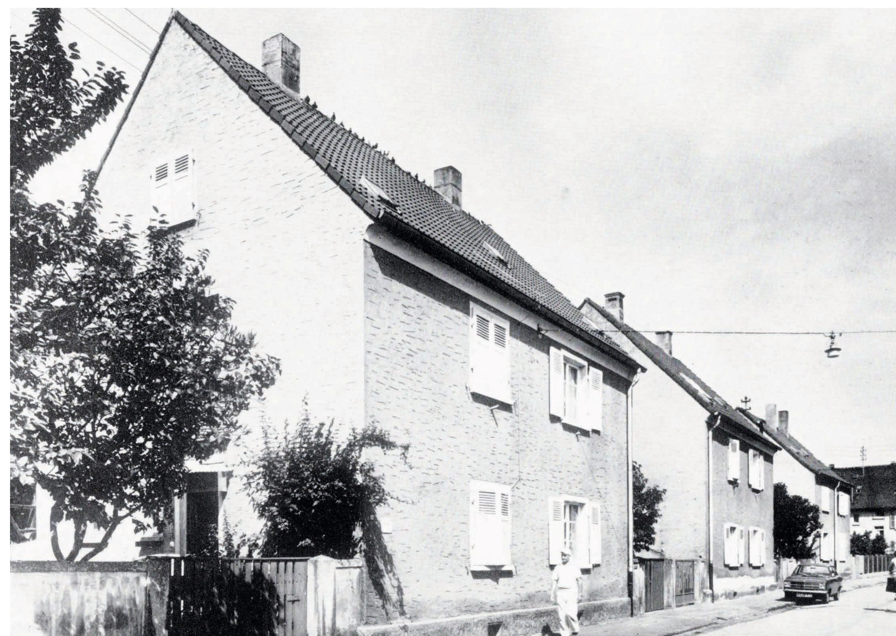
Die ersten Doppelhäuser in der Bühler Straße (ehemals Werder Straße) aus dem Jahre 1921. Stand 60er Jahre letzten Jahrhunderts.
