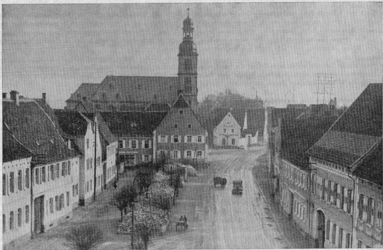
Ansicht: Der ehemaligen Planken (in Höhe Rathaus)
