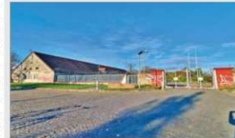
Anders als auf vielen anderen Konversionsflächen, hat sich auf Stem baulich noch nichts getan. Foto: Schillinger
