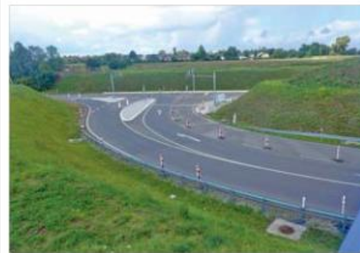
Neue Wegführung für und zur neuen Neckarbrücke. Foto: Schillinger
