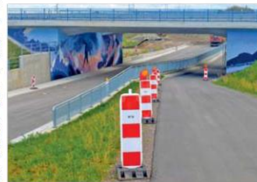
Die Arbeiten sind in vollem Gang.
